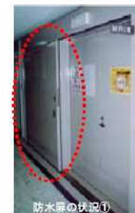
防水扉の状況①
