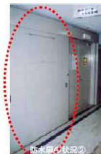
防水扉の状況②
