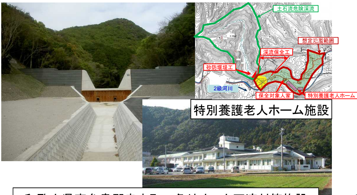
和歌山県東牟婁郡串本町二色地内 土石流対策施設 (砂防堰堤及び渓流保全工)
