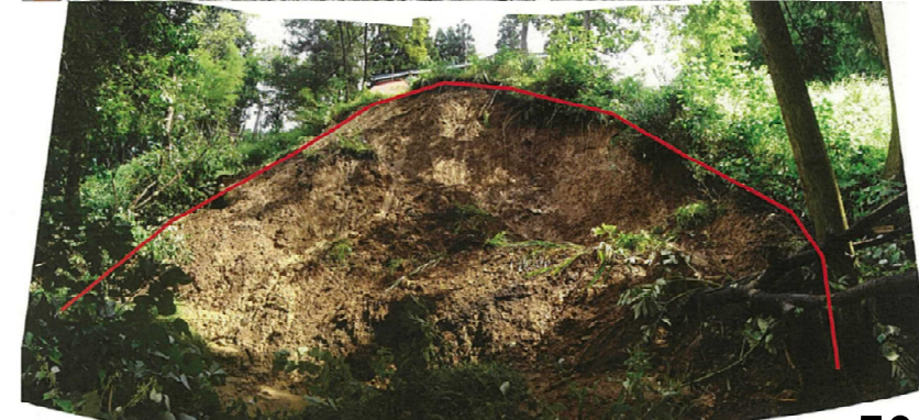
民家裏の斜面で崖崩れ(糸魚川市大字崩)
