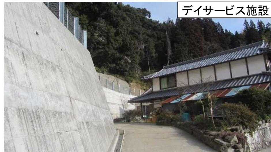
大分県豊後大野市余所萩地区 急傾斜地崩壊防止施設 (重力式待受擁壁)
