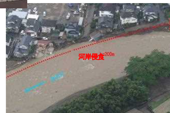
河岸侵食に伴う 家屋倒壊等
