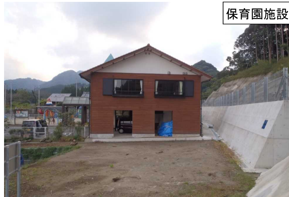
宮崎県宮崎市鏡洲地区 急傾斜地崩壊防止施設 (重力式擁壁)
