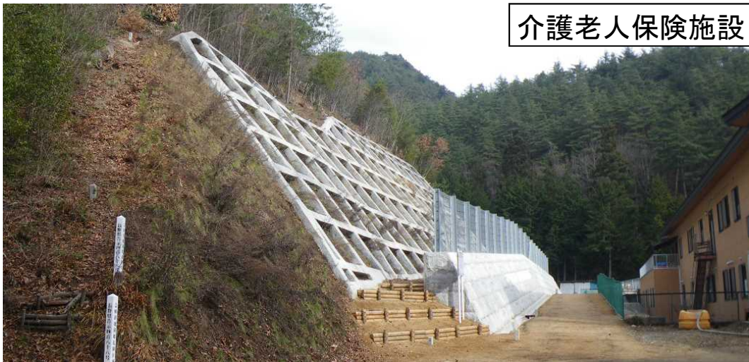
長野県安曇野市有明地区 急傾斜地崩壊防止施設 (重力式待受擁壁)
